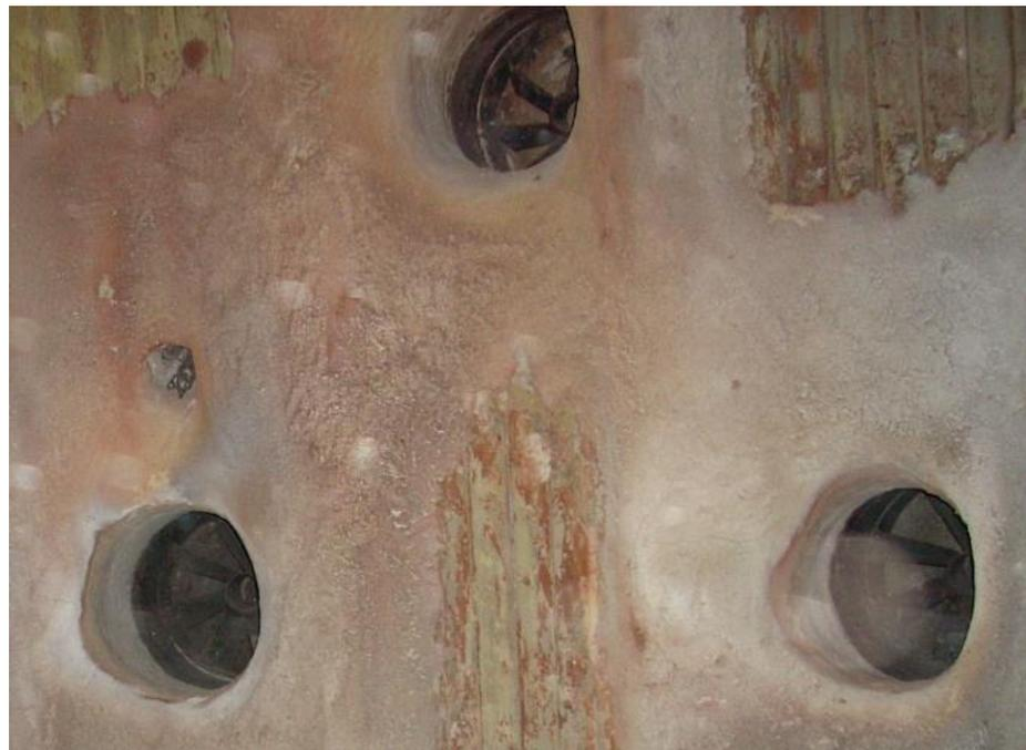
**Установка горелок в котле КВГМ-100 (треугольником вверх 3 горелки на фронте котла)**
