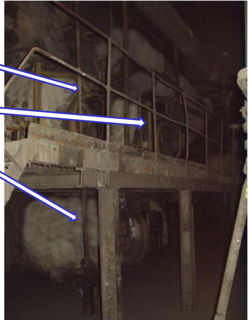
С целью снижения выбросов оксидов азота ( $\text{NO}_x$ ) на 45 – 50 % разработано горелочное устройство стадийного сжигания природного газа для реконструкции мощных паровых котлов ТЭЦ типа ТП-170 и др.
