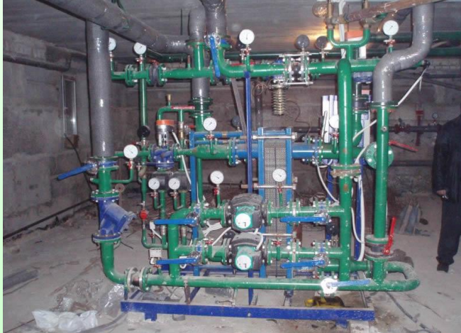
Рис- ІТП з пластинчатим теплообмінником
