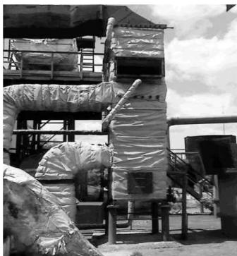
**Контактна комбінована теплоутилізаційна установка**
