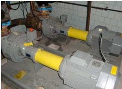
Циркуляционные насосы сточных вод, установленные в КНС
