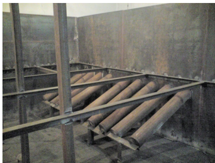
Фото 1. Внутренний вид бака аккумулятора с установленными нагревателями.
