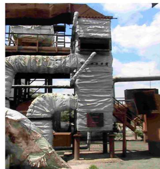
Контактна комбінована теплоутилізаційна установка
