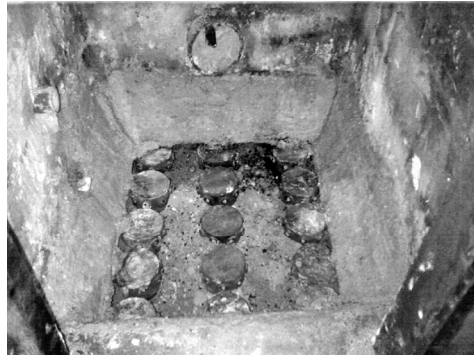
Рис. 6. Торкретування топки
