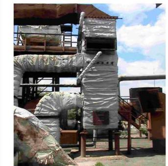
Контактна комбінована теплоутилізаційна установка
